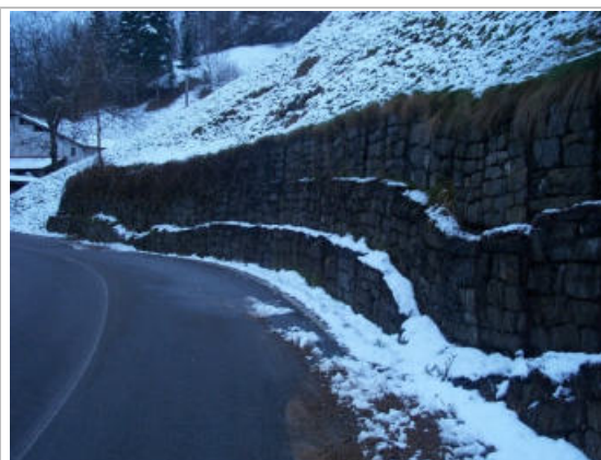
Foto 15 – Particolare dell'infossamento delle gabbionate lungo la strada per Dossena, nel tratto soprastante la testata dell'impluvio in dissesto.
